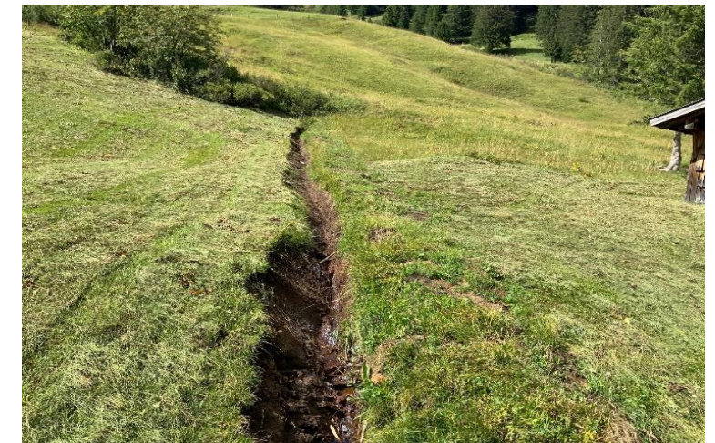
Reprofilage manuel correct du fossé en forme de V
