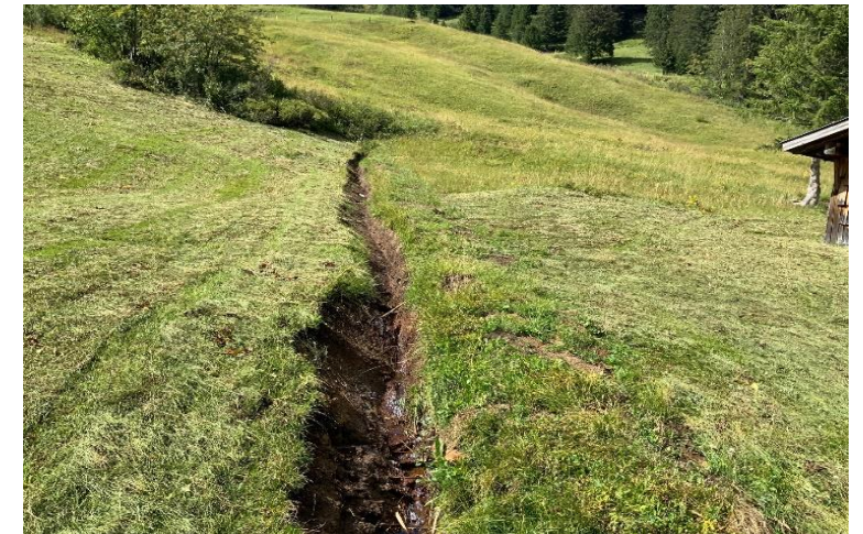
Sachgerecht mit Spaten, V-förmig nachgezogener Entwässerungsgraben
